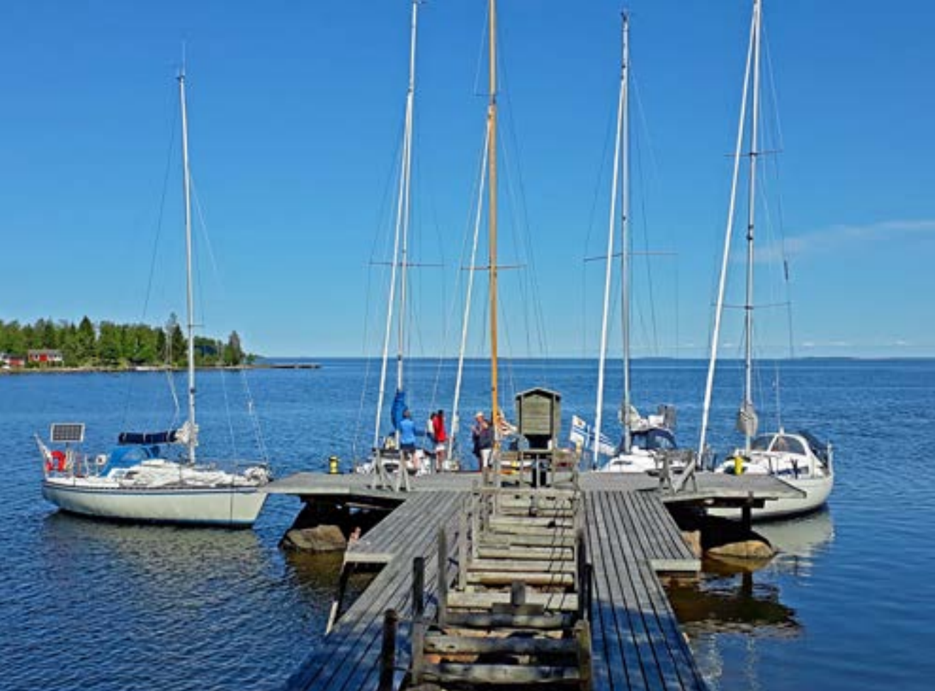
Hamnskärs fina brygga gjordes först klar för att underlätta kommande byggarbeten.
